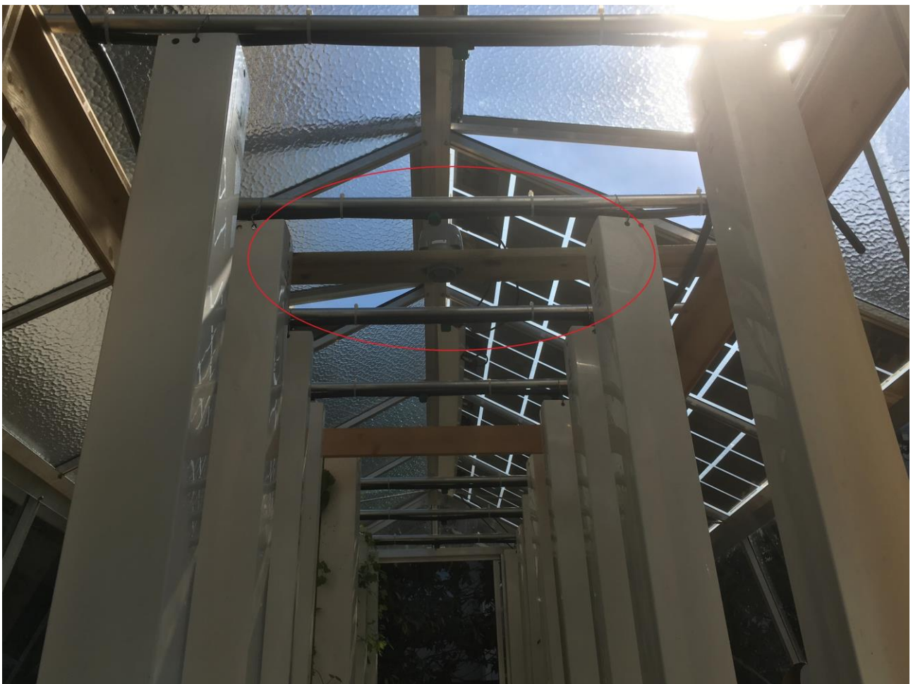
Figure 9 : Photo de l'installation du capteur de niveau d'eau
